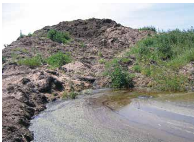
▲ Figure 13 : Le captage et le traitement des hydrocarbures qui suintent du sable pollué entassé sur le site de stockage temporaire empêchent la contamination de la zone et des eaux souterraines voisines.
