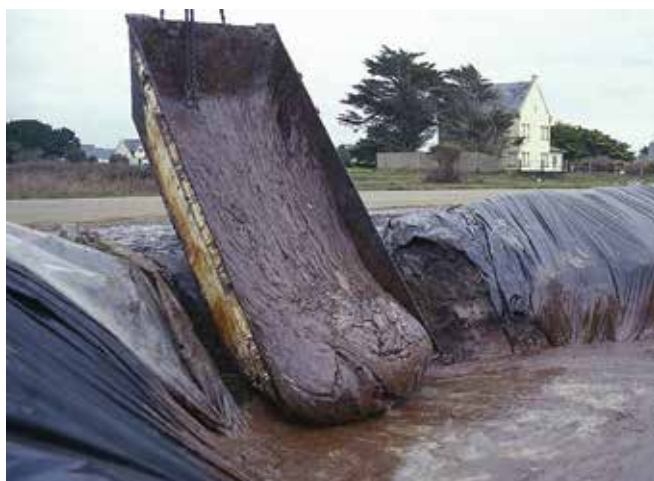
▲ Figure 11 : Fioul émulsionné transvasé d'une benne vers une fosse de stockage temporaire étanchéifiée.
