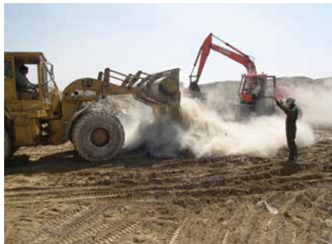
▲ Figure 18 : Stabilisation de déchets pollués à la chaux vive.
