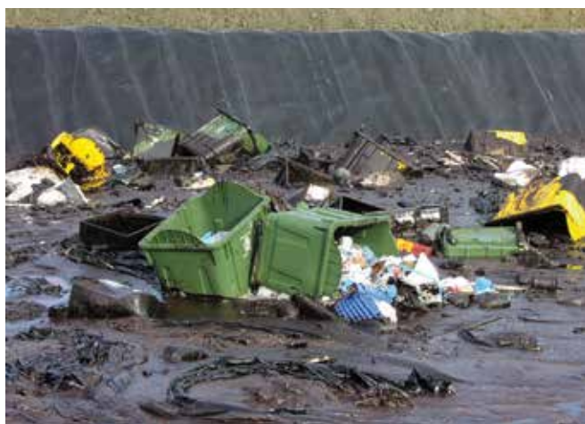
▲ Figure 9 : Fosse bien étanchéifiée contenant différents types de déchets mélangés, nécessitant un effort supplémentaire considérable au niveau du tri et du traitement.
