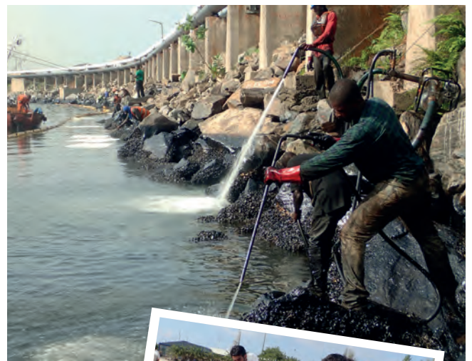
Nettoyage d'une infrastructure portuaire au Ghana
