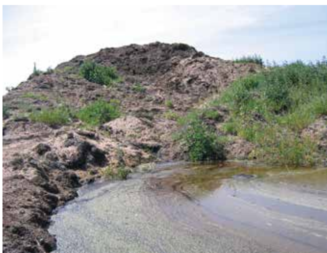
▲ Рис. 13: Удержание и обработка загрязнителя, просочившегося из нефтесодержащего песка, размещенного на временное хранение, предотвращает вторичное загрязнение окружающей территории и грунтовых вод.
