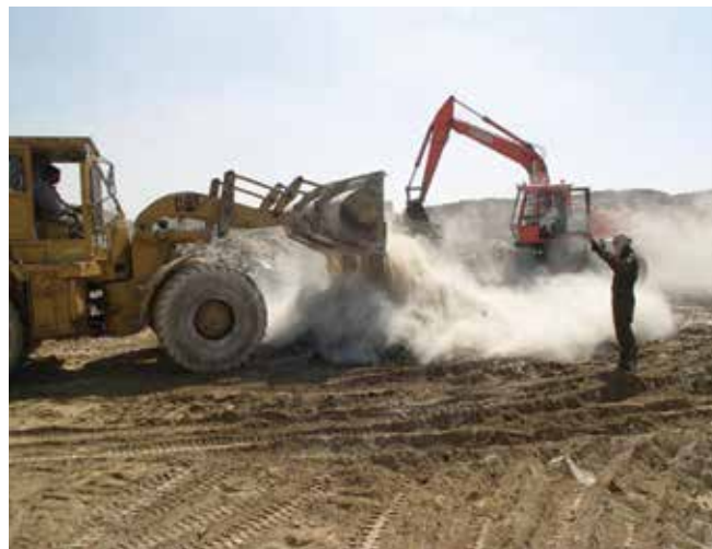
▲ Рис. 18: Стабилизация нефтесодержащих отходов с помощью негашеной извести.
