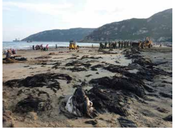
▲ Şekil 13: Denizde plana göre yerleştirdikten sonra yüksek gelgitte bir sahil şeridinde karaya oturan emici maddeden yastıklar. Hızlı bir şekilde kaldırılmadıkça, sonraki gelgitler boyunca kum hareketi yastıkları örtecektir, geri toplamayı engelleyecektir.
