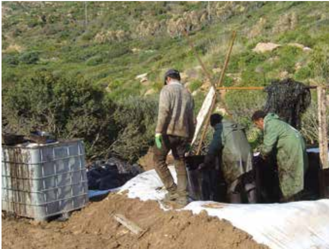
▲ Şekil 16: Petrolün bir kap içerisine akmasına olanak sağlamak, böylelikle atık içerisindeki serbest petrol miktarının en aza indirilmesi için bir direğe asılan toplanmış emici maddeden kapan.
