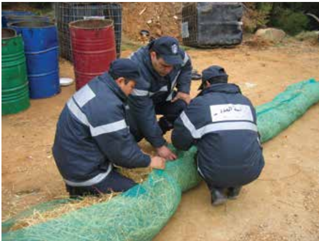
▲ Şekil 2: Saman ve ağdan inşa edilen eğreti emici madde engelleri. Bu gibi engeller ucuz olmaktadır ve inşa edilmeleri kolaydır ve uygun alanlarda plana göre yerleştirildiklerinde etkili kısa vadeli koruma sağlayabilmektedir.
