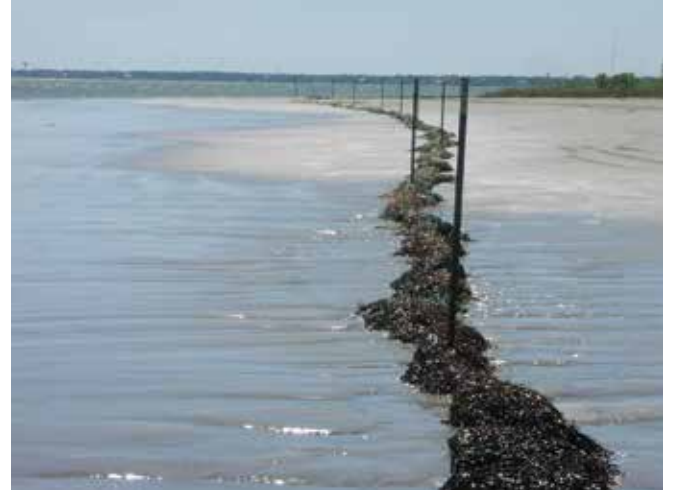
▲ Şekil 7: Su yüzeyindeki petrol tabakasını yakalamak için bir halîç boyunca ipe dizilen kapan. Açık yapı ve malzemenin geniş yüzey alanı akışmaz petrolerin toplanmasına özellikle uygun olmaktadır.
