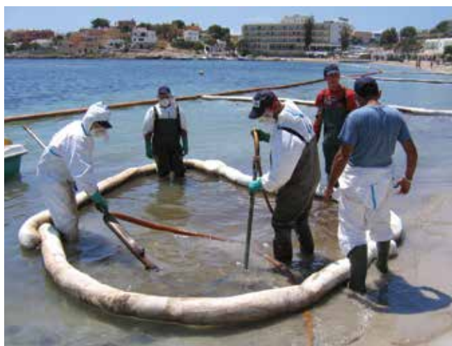
▲ Рис. 1: Полипропиленовый сорбирующий бон, используемый для сбора нефти, высвобожденной во время операций промывки.
