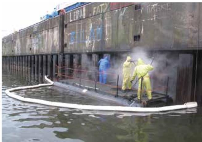
▲ Рис. 30: Замасленные сваи и причалы в доках промываются под давлением с небольшого плота. Высвобожденная нефть собирается сорбирующим бонном.
