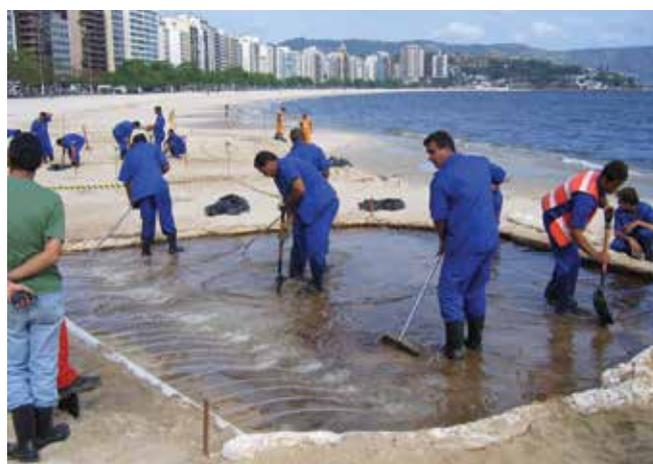
▲ Рис. 16: Нефть, погруженная в песчаный пляж, смывается водой под низким давлением, подаваемой по шлангам и перфорированным трубам. Нижний слой также взбалтывается вручную, чтобы вызвать отделение нефти от песка. После этого нефть собирается сорбирующим боном, окружающим рабочий участок.
