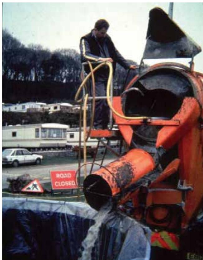
▲ Рис. 24: Выпускная струя из арузовика для перевозки бетонной смеси после промывки гальки и небольших обломков породы.
