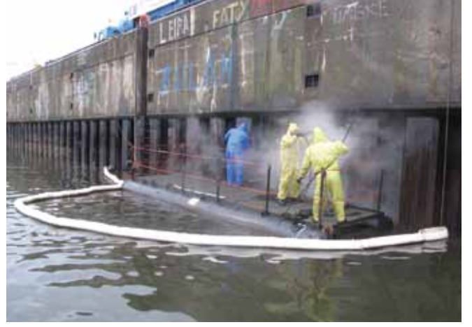
▲ الشكل رقم 30: أكوام من الأحجار الملوثة بالنفط ورصيف مخصص لربط السفن يجري تنظيفها بواسطة الضغط من قاربٍ طافٍ صغير. يتم تجميع النفط المنبعث في حاجز تطويق طافٍ ماص.
