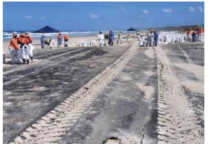
الشكل رقم 6: يمكن أن يؤدي استخدام الماكينات على السواحل الملوثة بالنفط إلى تلوث إضافي. هنا مرت الشاحنات من فوق المنطقة الملوثة بالنفط، مما دفع بالنفط إلى داخل رمال الشاطئ.
