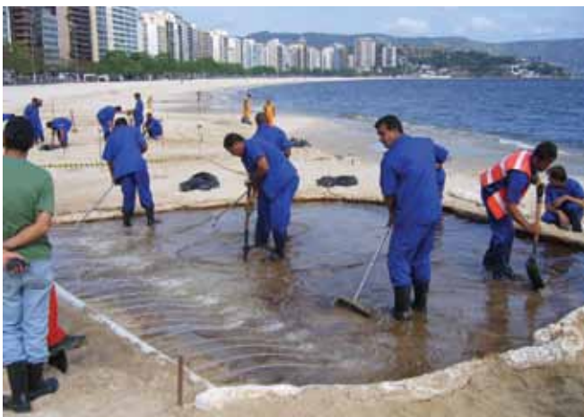
الشكل رقم 16: يغسل النفط المدفون داخل شاطئ رملي باستخدام مياه منخفضة الضغط التي تجري من خلال قنوات وأنابيب مثقبة. كما يتم إثارة ركيزة الشاطئ يدوياً لإرغام النفط على الانفصال عن الرمال. ثم يستعاد النفط من خلال حاجز تطويق طاف ماص يحيط بمنطقة العمل.
