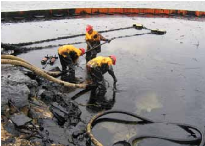
الشكل رقم 3: استعادة نفط سائب سائل من السواحل باستخدام جهاز كشط ذي مسحة معلقة بحبل ومضخات تفريغ.
