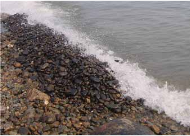
▲ الشكل رقم 20: يُنقل الحصى الكبير الملوث بالنفط إلى منطقة الأمواج ليتم غسله.
