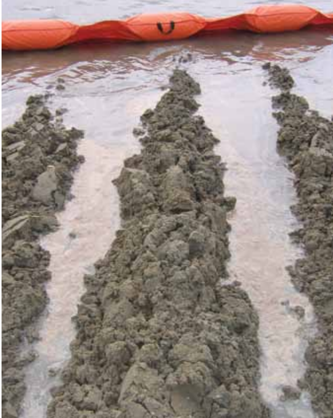
الشكل رقم 25: يتم دفع ركيزة الشاطئ الملثة إلى السطح من خلال عمليات الحرث. ثم يطلق النفط مع قذرم المد ليتم تجميعه على حافة المياه.
