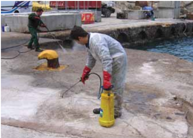
الشكل رقم 23: مادة تنظيف كيميائية للساحل توضع على بقعة من النفط ويعقب ذلك الغسيل بالضغط.
