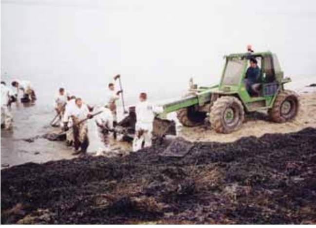
▲ الشكل رقم 8: الإزالة اليدوية للنفط والطحالب البحرية الملوثة بالنفط إلى دلو تليسكوبي. تتيح هذه الطريقة اختيار المادة الملوثة بالنفط تفضيلاً لها على المادة النظيفة، مما يقلل كمية النفايات.
