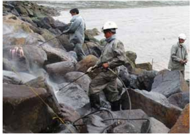
▲ الشكل رقم 32: تنظيف صخور حماية الشاطئ باستخدام أجهزة غسل عالية الضغط.
