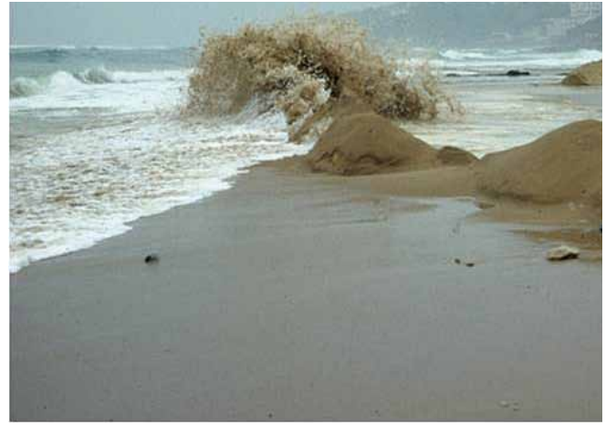
▲ الشكل رقم 19: يتم غسل الرمال المكوّمة بفعل المد القادم لإعادة تحريك النفط العالق. (الصورة مهداة من "برنارد فيتشاو"، جامعة بريطانيا-برست).
