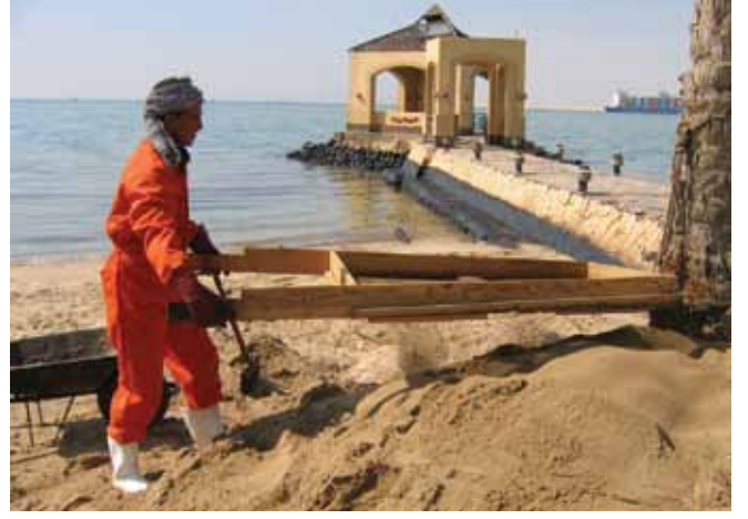
الشكل رقم 27: غربال مرتجل لتجميع كتل القطران.
