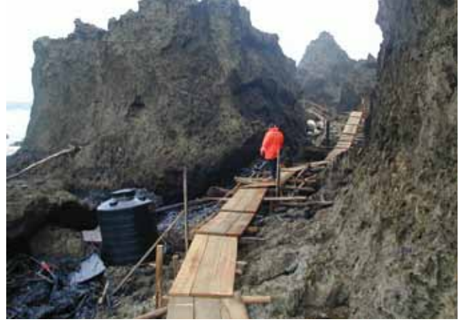
▲ الشكل رقم 35: لتقليل الأخطار التي يتعرض لها العمال على السواحل الصخرية، يمكن إنشاء ممرات مؤقتة.
