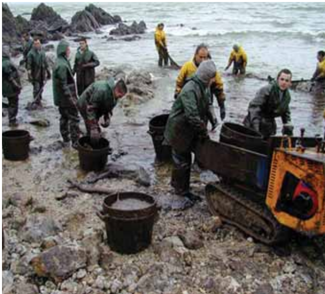
الشكل رقم 1: الإزالة اليدوية للنفط السائب. يقلل استخدام الطاقة البشرية للاستعادة الانتقائية للنفط من السواحل من كمية المواد النظيفة التي يتم إزالتها.
