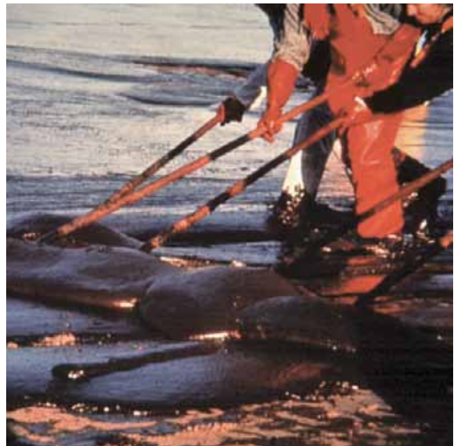
▲ الشكل رقم 12: يكشط النفط الخام بطول شاطئ رملي كثيف الرمال لكي يتم تجميعه في خنادق ثم استعادته من خلال شاحنات التفريغ لينقل بعد ذلك إلى مكان التخلص منه.
