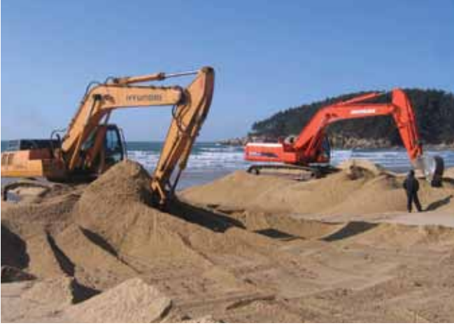
▲ الشكل رقم 18: يتم نقل الرمال الملوثة بدرجة خفيفة إلى منطقة الأمواج الواقعة بين المد والجزر لتغسلها موجات المد المتعاقبة.
