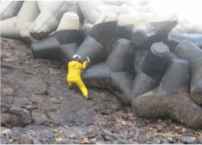
▲ الشكل رقم 33: يمثل تنظيم الحواجز الرباعية الملوثة بالنفط مشكلة، نظرًا لصعوبة الوصول إلى النفط داخل الهيكل.
