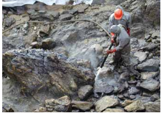
▲ الشكل رقم 17: تستخدم المياه منخفضة الضغط لغسل النفط من بين الصخور، ليتم تجميعه بواسطة مادة ماصة في مكان آخر أسفل الساحل.
