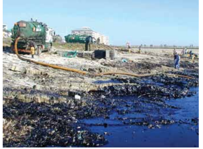
▲ الشكل رقم 8: تؤدي إتاحة أنظمة التفريغ على نطاق واسع إلى جعل هذه الأجهزة مثالية في عمليات استعادة النفط على السواحل أو بالقرب منها.
