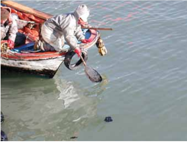
الشكل رقم 22: صياد يستخدم مجرفة تحتوي على شبكة لاستعادة كتل صغيرة من نفث وقود عالي اللزوجة.
