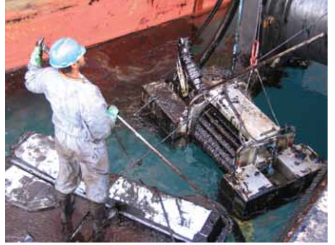
▲ الشكل رقم 17: جهاز كشط برميلي ميكانيكي يتم استخدامه في منطقة ميناء. السنون الموجودة على البرميل الدوار تسحب النفط في اتجاه الجهاز حيث تتم استعادته إلى داخل البرميل وضخه إلى مكان التخزين. يصنع البرميل من شبكة لتقليل استعادة المياه.
