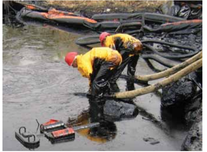
▲ الشكل رقم 10: العمّال يضعون خرطومًا متّصلًا بمضخة تفريغ في النفط مباشرة. في هذه الحالة، تم نزع وصلة الحاجز الغاطس الصغيرة للسماح لنفط الوقود اللزج بالتدفق إلى داخل الخرطوم، مع إمكانية زيادة المياه المحمولة نتيجة لذلك.
