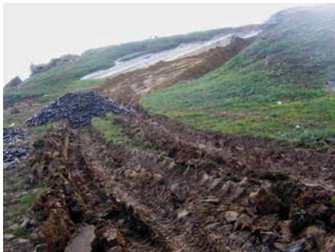
▲ Рис. 15: Поле, серьезно пострадавшее от движения тяжелого машинного оборудования к загрязненной береговой линии и обратно. Для возмещения ущерба проводится инспекция, которая устанавливает точный размер ущерба, а также определяет, будут ли восстановительные работы к улучшению качества объекта.
