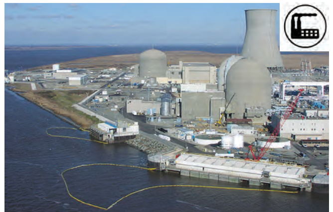
▲ 그림 6 : 발전소 취수구 전면. 다수의 오일펜스가 기름의 유입을 방지하기 위해 전장된다.
