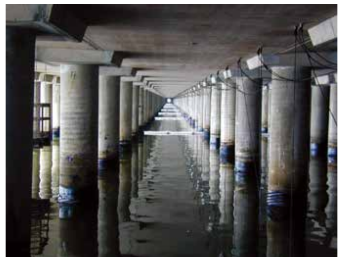
▲ 図5: 頭上空間が少なく通気が悪いため、洗浄作業員が埠頭の下に入り込むのは難しく危険な場合がある。
