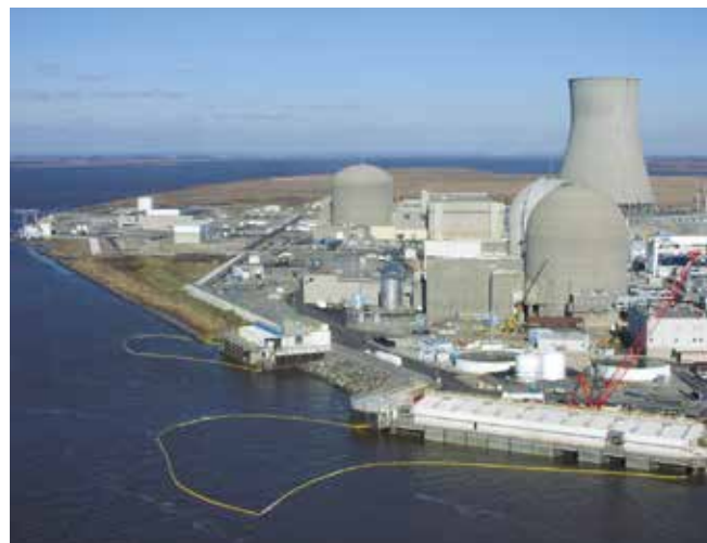
▲ 図7: 油が熱交換器に悪影響を与えないよう取水口を保護すべきである。熱交換器に油が入ると洗浄が難しいため、施設の閉鎖につながりかねない。
