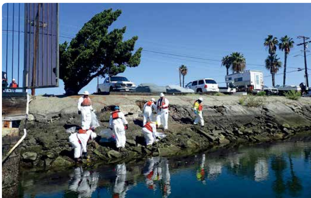
ISTRA ACE 号：工人从码头的裂缝和桩柱上清理油污
