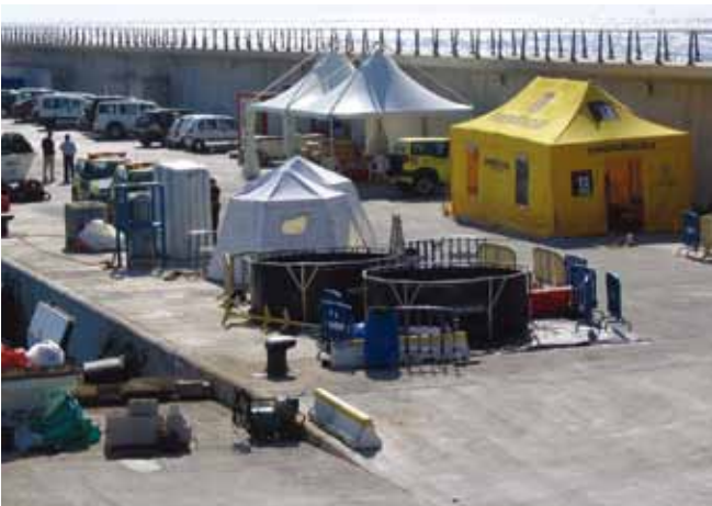
▲ 图 45：在工作现场附近搭建的临时建筑物为工作人员提供膳食和卫生设施。
