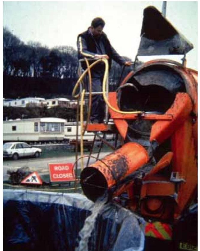
▲ 图 24：混凝土搅拌车在清洗细砾和小卵石后放出的污水。
