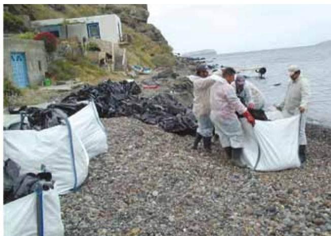
▲ 图 10：将小袋废物整合成容量为一吨的更大“集装袋”，以便于运往处置场所。
