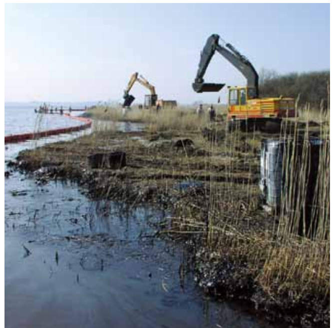
▲ 图 41：在海岸线上的敏感区域使用重型机械设备可能会造成严重的额外破坏。在这种情况下，快速回收自由漂浮的油类是优先需要做到的。
