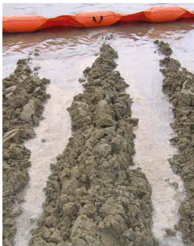
▲ 图 25：通过犁的方法将受污染的海滩底物翻到表面上来。之后，涨上来的潮水便会使油类释放出来以便在水面边缘处回收。
