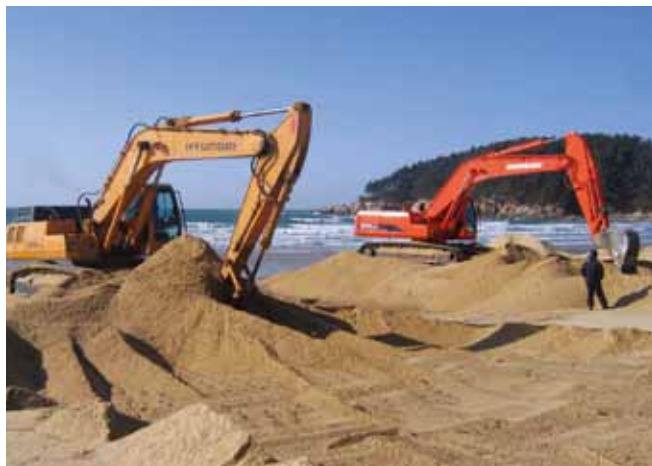
▲ 图 18：将轻度污染的沙子移往潮间海浪区域，以使其在之后的潮汐期间得到洗涤。
