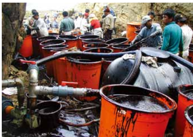
▲ 图 13: 在多岩石海岸线上回收的油类临时储放在大型的开口桶中。需要使用泵将这些油转移到悬崖顶上, 然后再转移到油罐车上。
