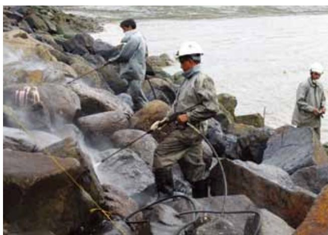
▲ 图 32：使用高压清洗装置清洗抛石。
