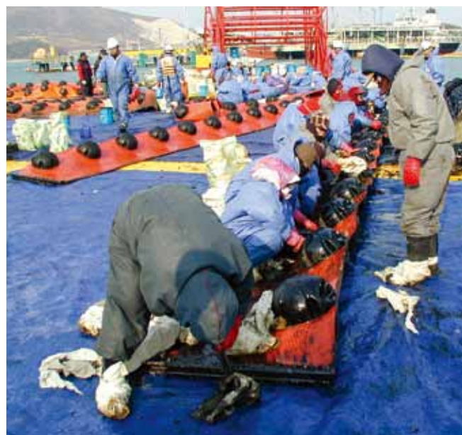
▲ 图 6: 困在篱笆式栅栏外置浮物后面的油类可能尤其难以清理。
