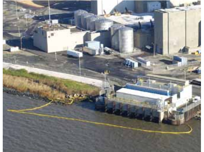
▲ 图 13: 帘式栅栏部署在发电站的冷却水入口前方。
