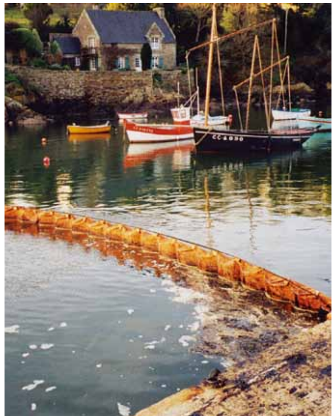
▲ 图 1：引导油类从锚定处流走的篱笆式栅栏。
