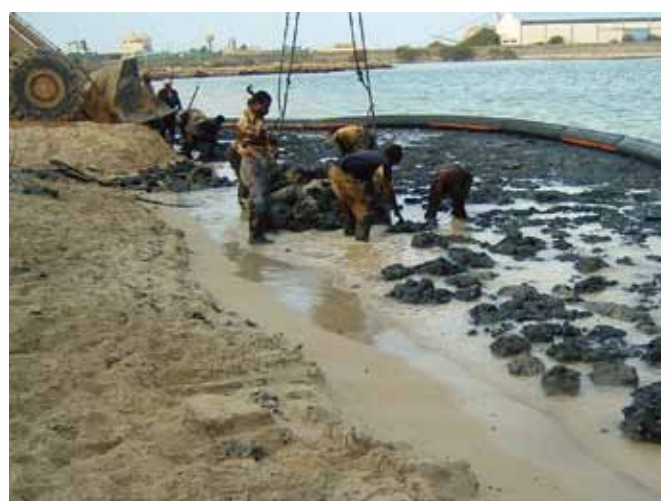
▲ 图 19: 充气式栅栏的一个分段将半固态油类堵在海岸线上, 以便于回收。
