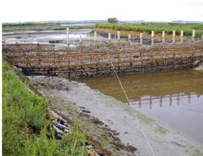
▲ 图 21：用贝壳堆成、用桩和网固定的障碍物。
