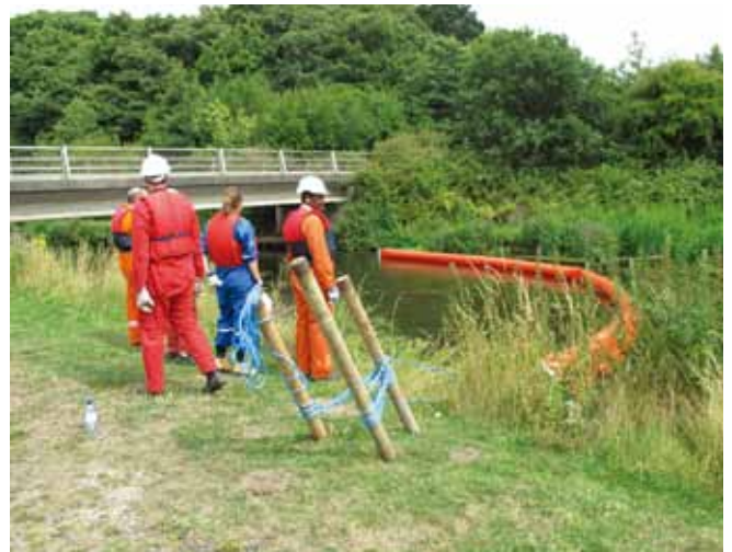
▲ 图 17: 在没有树木或其他天然下锚点的海岸线上用来系留栅栏的锚定桩。
