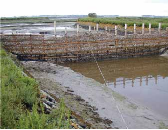
▲ الشكل رقم 21: حاجز مصنوع من قشور المحار، مثبت في مكانه بواسطة أعمدة وشبكات.
