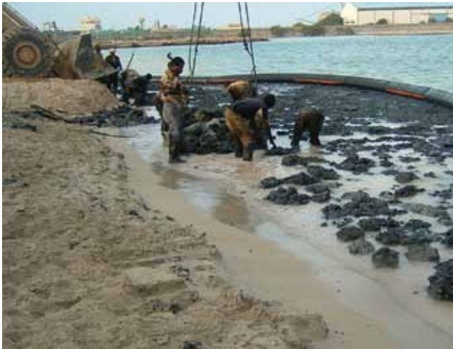
▲ الشكل رقم 19: نفط نصف صلب متحجز في مواجهة شاطئ بواسطة مقطع من حاجز تطويق طافٍ قابل للملء بالهواء لتسهيل استعادته.
