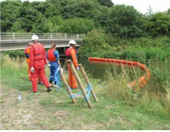
▲ الشكل رقم 17: أعمدة للربط تستخدم في الإمساك بحاجز التطويق الطافي في مكانه دون استخدام أشجار أو أية نقاط ارتكاز طبيعية.
