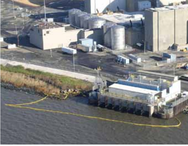
▲ الشكل رقم 13: حاجز غلالي تم وضعه أمام مدخل مياه التبريد لمحطة لتوليد الطاقة.
