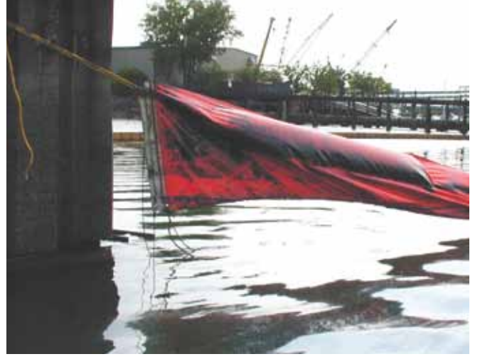
▲ الشكل رقم 16: تسبب استخدام طول غير كافٍ من أحبال الربط في جعل حاجز التطويق معلقًا عند انخفاض الجذر، مما يتيح للنفط المرور من أسفله. يجب ضبط الخطوط بصورة منتظمة للحفاظ على حاجز التطويق في وضع فعّالة على مدار دورة المد والجذر. قد يكون الرباط المنزلق أكثر فعالية في هذا السيناريو.
