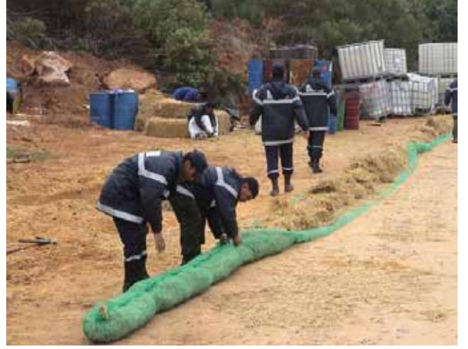
▲ الشكل رقم 20: حاجز تطويق طاقٍ ارتجالي مصنوع من النسيج الشبكي والقش. على الرغم أنه من غير المنتظر أن يدوم لأكثر من دورة واحدة من المد والجزر، إلا أن هذا قد يساعد في تقليل تلوث الساحل من جزاء النفط الطافي الوارد.
