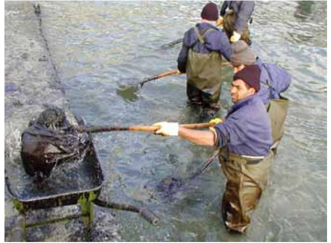
▲ 图 9：人工回收已经下沉的重质燃油。
