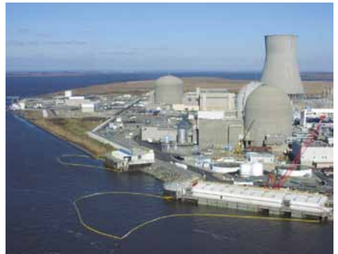
▲ 图 7：应该保护进水口，以防止油类影响热交换装置，此类装置很难清理，可能会导致设施关闭。
