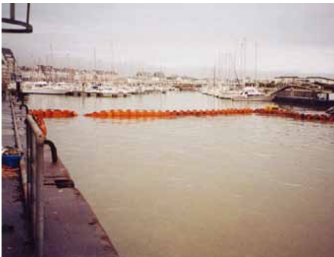
▲ 图 2：如果栅栏被进出的船只破坏，码头部署栅栏的成效可能会大打折扣。
