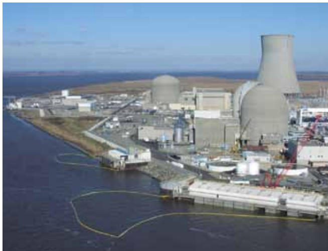
الشكل رقم 7: يجب حماية مداخل المياه لمنع النفط الذي يؤثر على المبادلات الحرارية والذي يمكن أن يصعب تنظيفه وقد يؤدي إلى إغلاق المنشآت.
