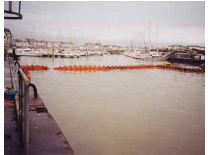
الشكل رقم 2: يمكن أن يفشل وضع حواجز التطويق الطافية بصورة ناجحة على مداخل المراسي إذا اتلفت المراكب الداخلة أو الخارجة تلك الحواجز.
