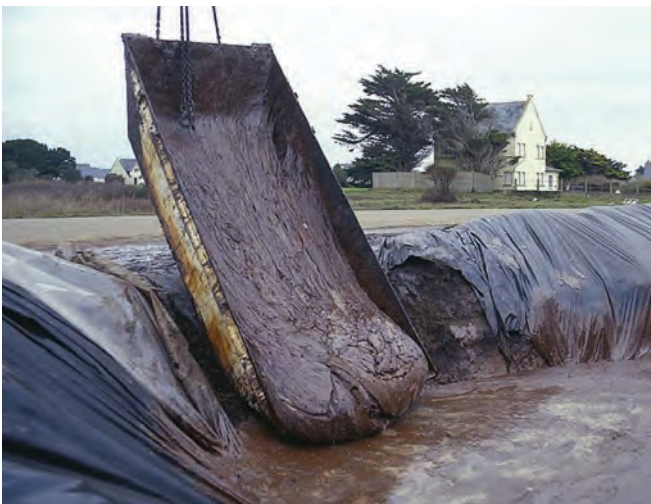
▲ 그림 11: 안감을 댄 임시 저장 구덩이에 저장되는 에멀전화 된 연료유.
