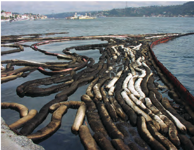
▲ 그림 7: 부분적으로 기름이 묻은 흡착재 붓. 폐기물 발생을 최소화하기 위해서 흡착재의 대량 사용을 막아야 한다.
