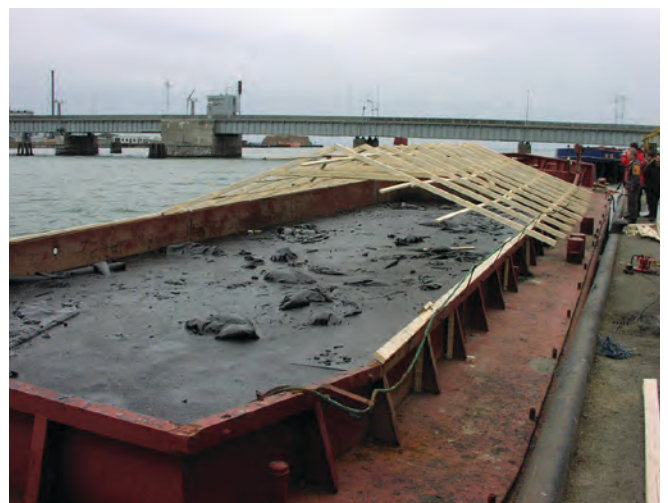
▲ 그림 10: 회수된 기름은 바지선에 저장한다. 빗물 유입을 막기 위해 뚜껑이 필요하다.
