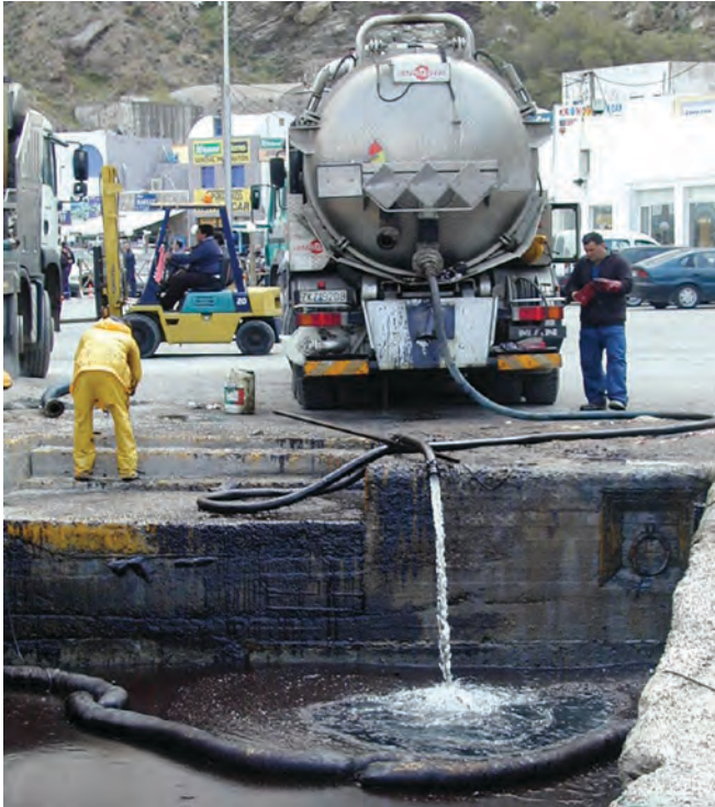
▲ 그림 15: 회수된 기름 묻은 물을 안정화 및 분리시킨 후, 진공 트럭에서 옮겨 붓기.
