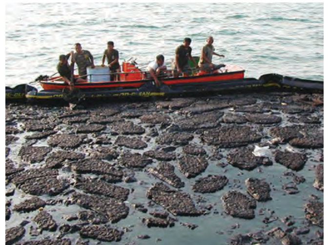
▲ 그림 6: 반고체 상태의 기름은 오일 불로 수거된다. 기름을 뽑아 올리는 어려움 때문에 이용 가능한 처리방식에 제한을 받는다.
