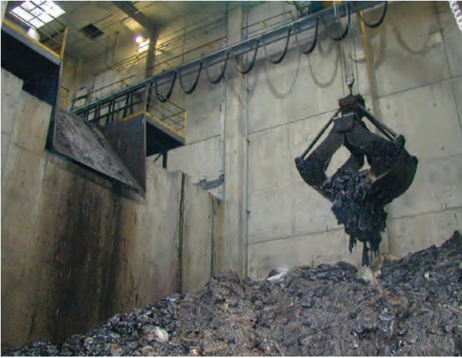
▲ 그림 19: 기름 묻은 폐기물 자루를 생활 폐기물과 공동 처리를 위해 대형 산업용 소각로의 이동 장치(loading chute)에 넣는다.
