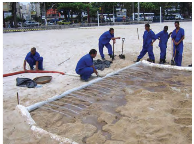
▲ 그림 1: 현장에서 저압 세척으로 기름 묻은 모래를 세척. 흡착재 붉은 방출된 기름을 적절하게 수거하기 위해 사용.
