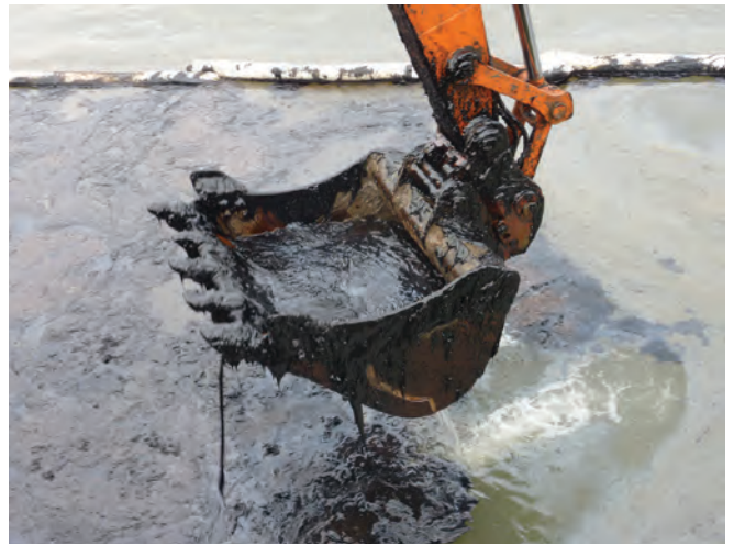
▲ 그림 21: 고점도 연료유의 회수를 위한 굴착기 작업. 버킷을 수면 약간 위로 들어 올린 상태를 잠시 유지하면서 유입수가 빠져나가도록함으로써 회수유의 농도가 극대화되었다. 이를 통해 후속적인 처리 비용이 절감되었지만, 회수 효율은 감소되었다.
