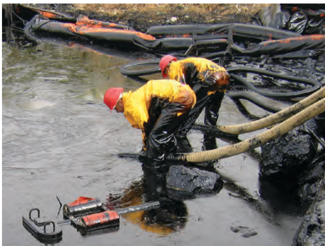
▲ 그림 10: 작업 인원들이 진공 펌프에 부착되어 있는 호스로 기름을 직접 회수하고 있다. 이 경우, 소형 위어 부품이 제거된 상태이기 때문에 고점도 연료유의 유입이 가능하지만 동반 유입수의 양이 증가할 가능성이 있다.
