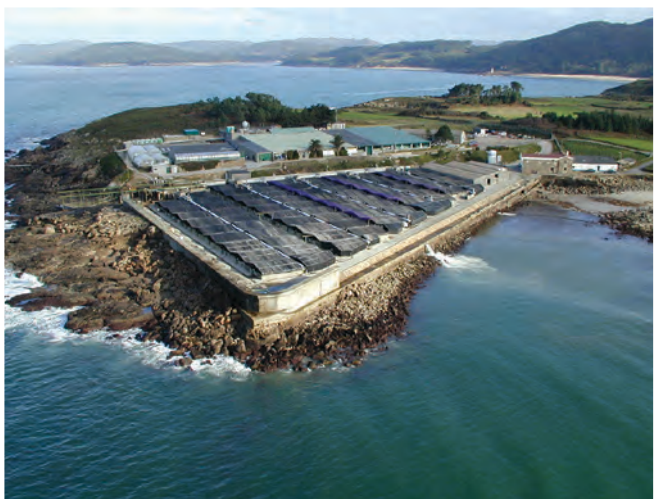
▲ 그림 7: 육상 양어장은 대량의 깨끗한 해수를 필요로 한다. 취수설비는 대개 해수면 아래에 위치하므로 분산유의 영향을 받을 수 있다.
