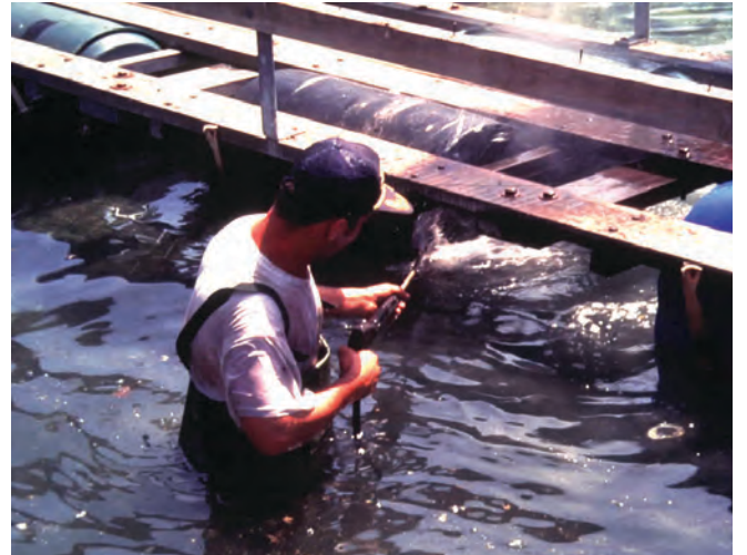
▲ 그림 11: 양식시설은 압력세척을 이용하여 현장에서 세척될 수 있다.
