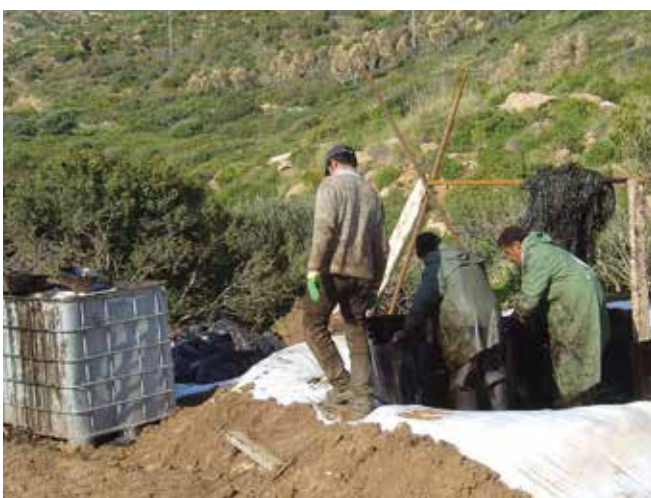
▲ 図16：回収された油吸着材スneaを竿に吊し、油を容器の中に落とす。これによって、廃棄物中の遊離油の量を最小限度に抑える。
