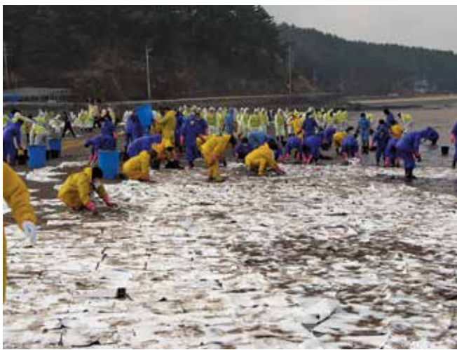
▲ 図9：固い表面の砂浜で油を回収するために油吸着材を大規模に使用する。油吸着素材の使用は、汚染規模に合わせて適切に行い、対応にとって目に見えるはっきりした利益をもたらさなければならない。また、処分の必要な廃棄物を不当に増やさないようにする。
