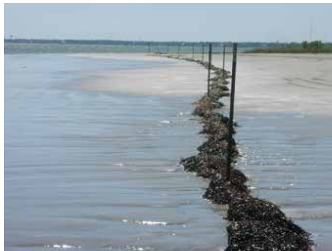
▲ 図7：浮遊油を捕捉するため、スネアをロープに吊して河口を横断するように配置した。素材の開放構造と大きな表面積は、特に高粘度油の回収に適している。
