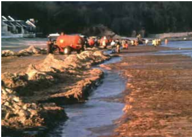
▲ 図4：溝の中に流し込まれた油を回収している農業用バキューム車。
