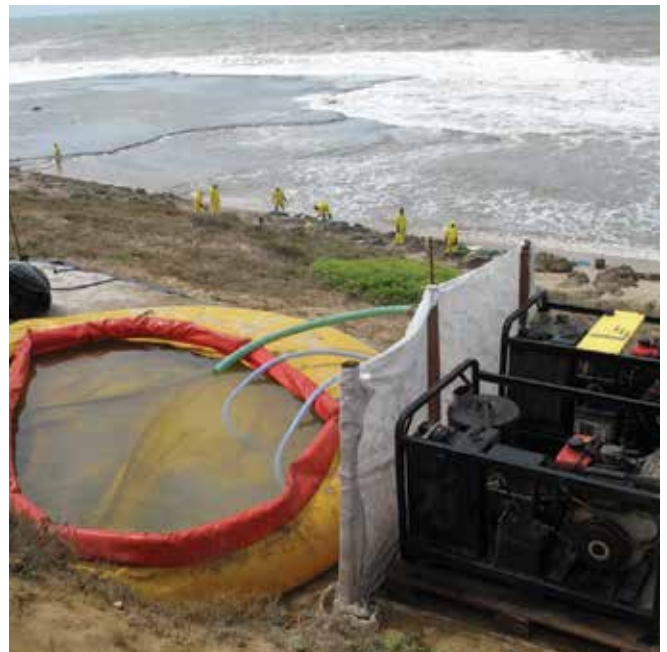
▲ 図22：離れた場所にある岩礁の圧力洗浄。海水は一時貯蔵タンクへポンプで汲み上げられ、隣の高圧洗浄機で使用される。
