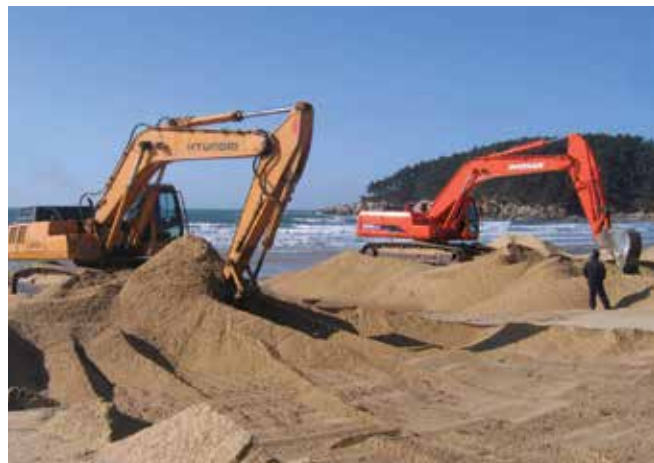
▲ 図18：軽度に汚染された砂は、潮間の磯波帯へ移され、その後の潮汐によって洗浄される。
