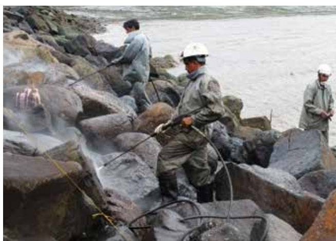
▲ 図32：高圧洗浄機による捨て石の清掃。
