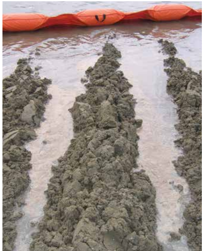
▲ 図25：汚染された海浜の基層は、掘り起しによって表面へ移される。次に、油は上げ潮で分離され水際で回収される。
