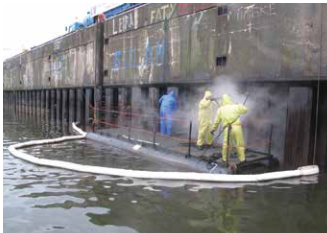
▲ 図30：小型筏で高圧洗浄される、油で汚染された杭と岸壁。流れ出た油は、吸着型オイルフェンスで回収される。
