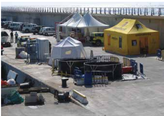
▲ 図45：作業現場の近くに仮設の建物を設け、作業員に食事と衛生に関する便宜を提供する。
