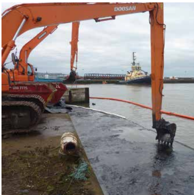
▲ 図5：港湾地区で油を回収している土木機械。この状況では、水温が油の流動点より低く油が半固体になっているため、油回収機を使用できなかった。
