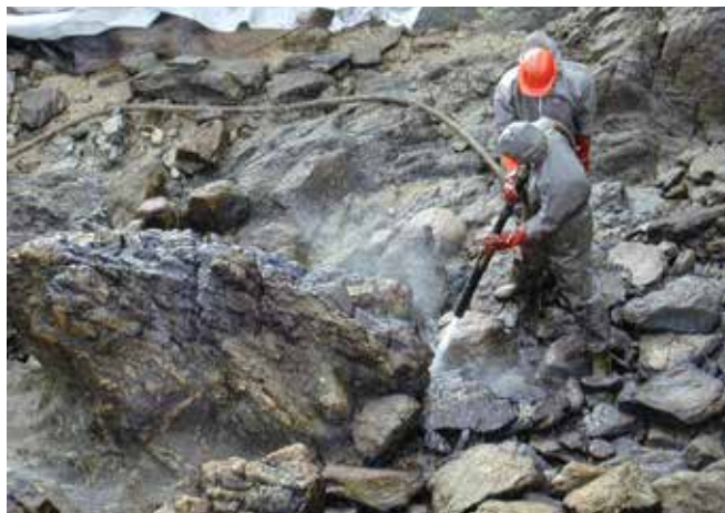
▲ 図17：低圧水を使って岩の間に入った油を流し出し、吸着材で海岸線に沿って回収する。
