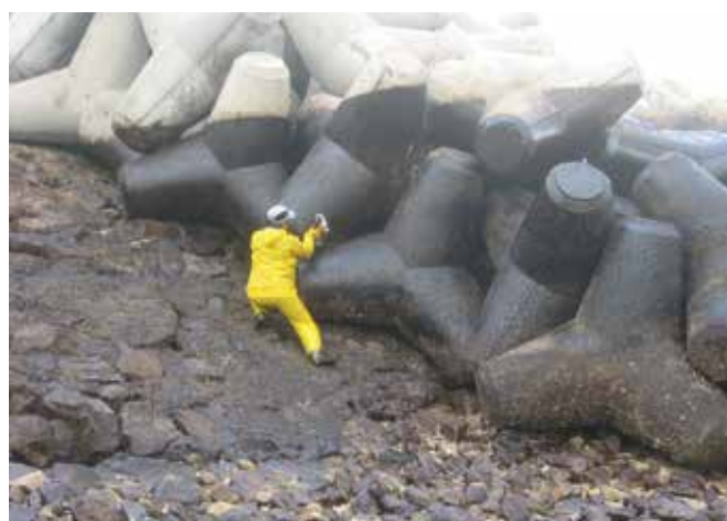
▲ 図33：油で汚染されたテトラポッドの清掃は、隙間に入った油には容易に手が届かないため、厄介である。
