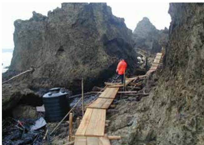
▲ 図35：岩場のある海岸線では、作業員の危険を最小限度に抑えるために、仮設通路を設けることがある。
