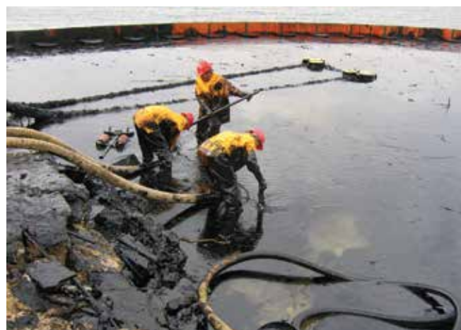
▲ 図3：ロープモップ式油回収機と真空ポンプを使用して、大量の流動性のある油を海岸線から回収。
