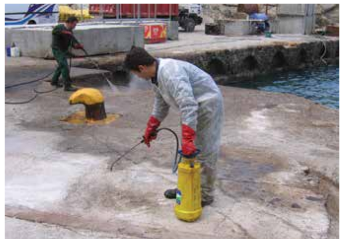
▲ 図23：圧力洗浄を行う前に、油汚れの個所に散布される海岸線洗浄用薬剤。
