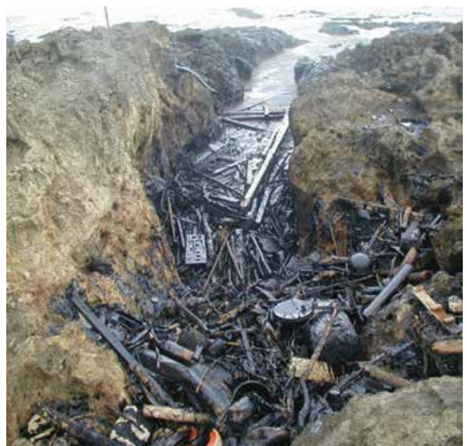
▲ 図34：岩場のある海岸線では、油と油混じりのゴミが潮だまりや割れ目に集まるため、手作業による大がかりな清掃作業が必要になる。
