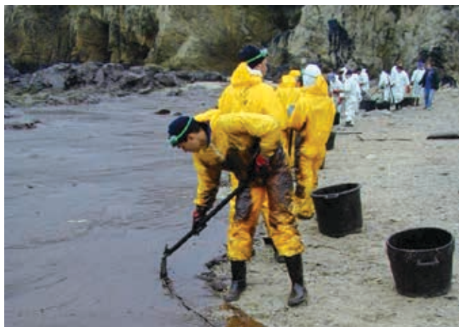
▲ Figura 38: recolección manual de fueloil emulsionado de una playa de arena gruesa.
