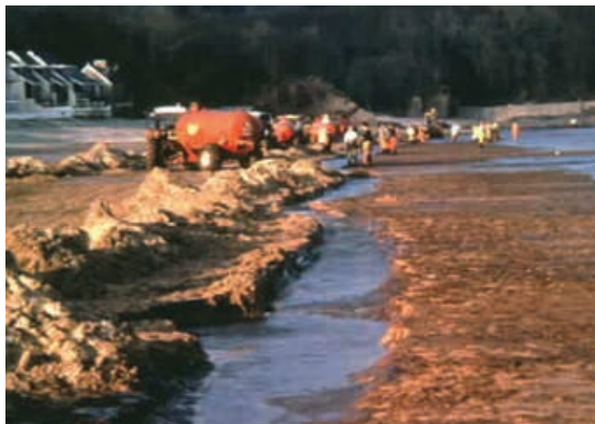
▲ Figura 4: cisternas agrícolas de aspiración recolectan hidrocarburos introducidos en zanjas con chorros de agua.
