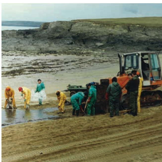
▲ Figura 44: el equipo de limpieza de costas óptimo se compone de 10 operarios; esto permite la supervisión eficaz y el avance de la tarea.
