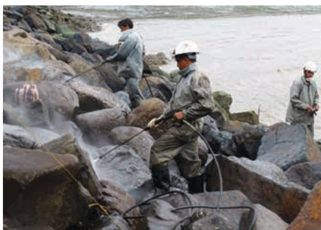
▲ Figura 32: limpieza de escolleras mediante equipos de lavado a alta presión.
