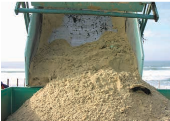
▲ Figura 7: la recolección directa mediante el uso de maquinaria pesada ha generado una elevada proporción de material limpio y concentraciones muy bajas de hidrocarburos en el residuo.
