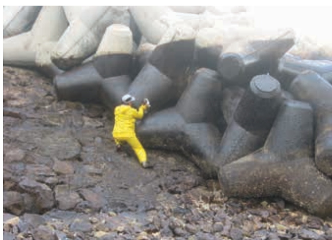
▲ Figura 33: la limpieza de tetrápodos contaminados plantea problemas porque es difícil acceder a los hidrocarburos en el interior de la estructura.
