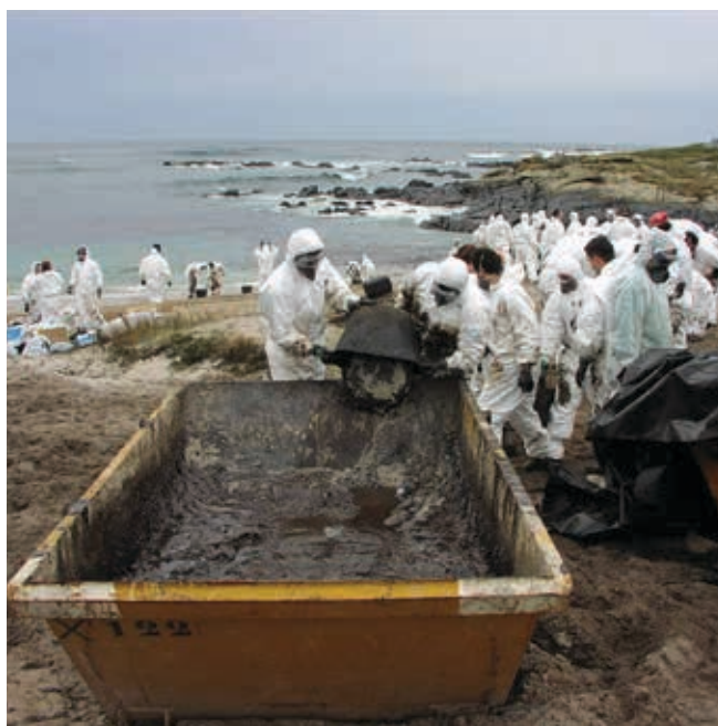
▲ Figura 15: una cadena de operarios vacía cubos de hidrocarburos y material de la playa contaminado por hidrocarburos en un contenedor que se utiliza para almacenamiento temporal.
