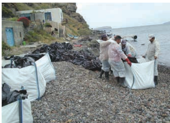
▲ Figura 10: las bolsas pequeñas de residuos se reúnen en sacos "big bag" de una tonelada para facilitar el transporte al lugar de desecho.
