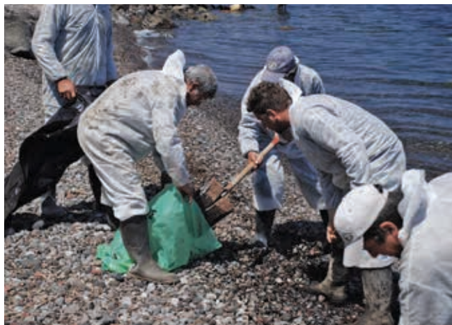
▲ Figura 36: recolección de guijarros pequeños contaminados por hidrocarburos en bolsas.
