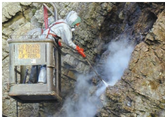
▲ Figura 21: lavado a presión de la cara de un acantilado por encima de una playa de recreo. Una tormenta arrastró los hidrocarburos hacia la parte superior del acantilado y probablemente persistiría durante cierto tiempo si no se realizara la limpieza.
