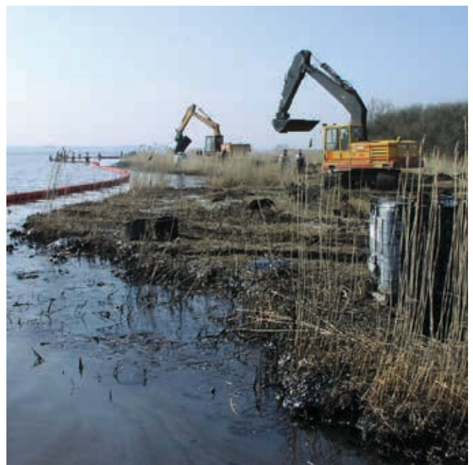
▲ Figura 41: el uso de maquinaria pesada en áreas sensibles de la costa podría provocar considerables daños adicionales. En este caso, se concedió prioridad a la necesidad de recolectar rápidamente los hidrocarburos que flotaban libremente.
