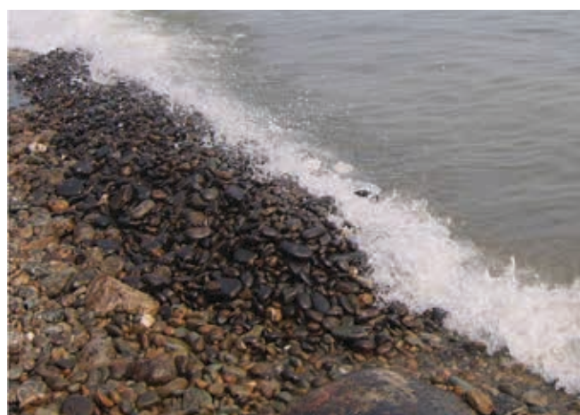
▲ Figura 20: transferencia de cantos rodados contaminados por hidrocarburos a la zona de oleaje para realizar el lavado.
