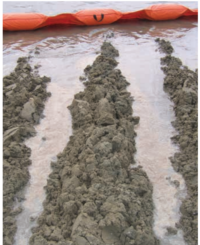
▲ Figura 25: el sustrato de la playa contaminado se expone a la superficie mediante arado. A continuación, el efecto de la marea entrante liberan hidrocarburos que se recolectan en el borde del agua.
