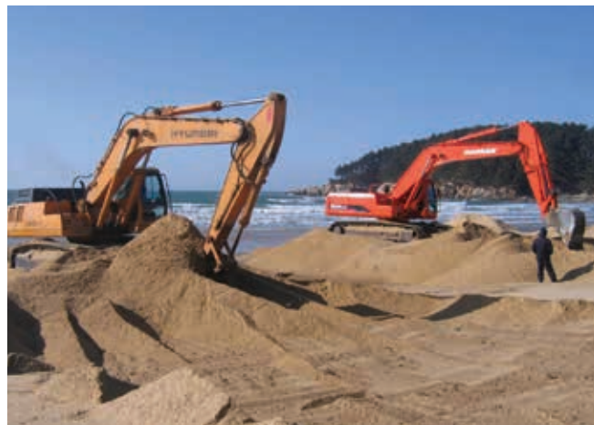
▲ Figura 18: la arena ligeramente contaminada se mueve hasta la zona de oleaje intermareal para que se lave durante mareas sucesivas.
