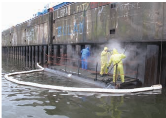
▲ Figura 30: lavado a presión desde una pequeña balsa muelle y pilares contaminados por hidrocarburos. Los hidrocarburos liberados se recolectan en la barrera adsorbente.
