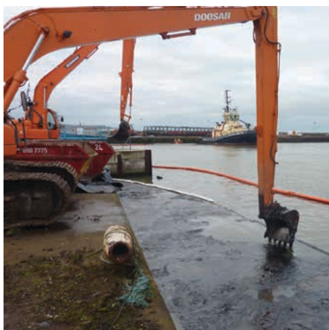
▲ Figura 5: uso de maquinaria de ingeniería civil para retirar hidrocarburos de un área portuaria. En esta situación, la temperatura del agua se encontraba por debajo del punto de fluidez de los hidrocarburos; por lo tanto, estos se encontraban en estado semisólido e impedían el uso de skimmers.
