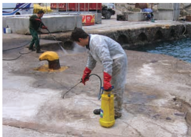
▲ Figura 23: aplicación de un producto químico de limpieza a una mancha de hidrocarburos, seguido de un lavado a presión.
