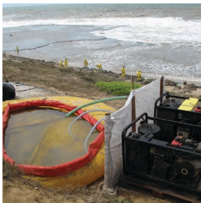
▲ Figura 22: limpieza a presión de un saliente de roca en una ubicación remota. Se bombeó agua de mar hasta el depósito de almacenamiento temporal mediante máquinas de alta presión adyacentes.
