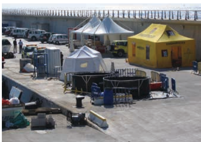
▲ Figura 45: construcciones provisionales, situadas cerca del emplazamiento de trabajo, sirven como instalaciones de avituallamiento y sanitarias para los operarios.
