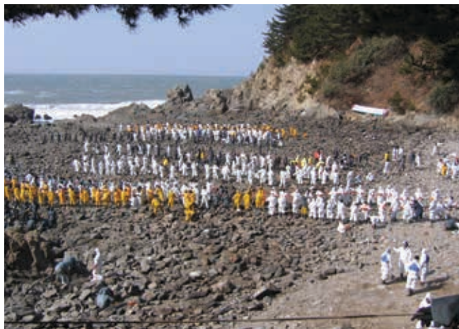
▲ Figura 14: cadenas de operarios que utilizan cubos de hidrocarburos y bolsas llenas permiten retirar con rapidez cantidades importantes de residuos de una costa.
