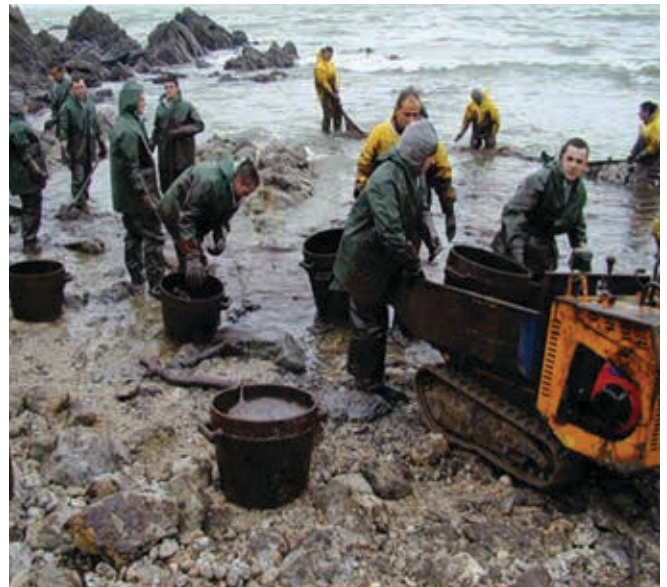
▲ Figura 1: retirada manual de acumulaciones de hidrocarburos. El uso de recursos humanos para la recolección selectiva de hidrocarburos de una costa minimiza la cantidad de material limpio retirado.
